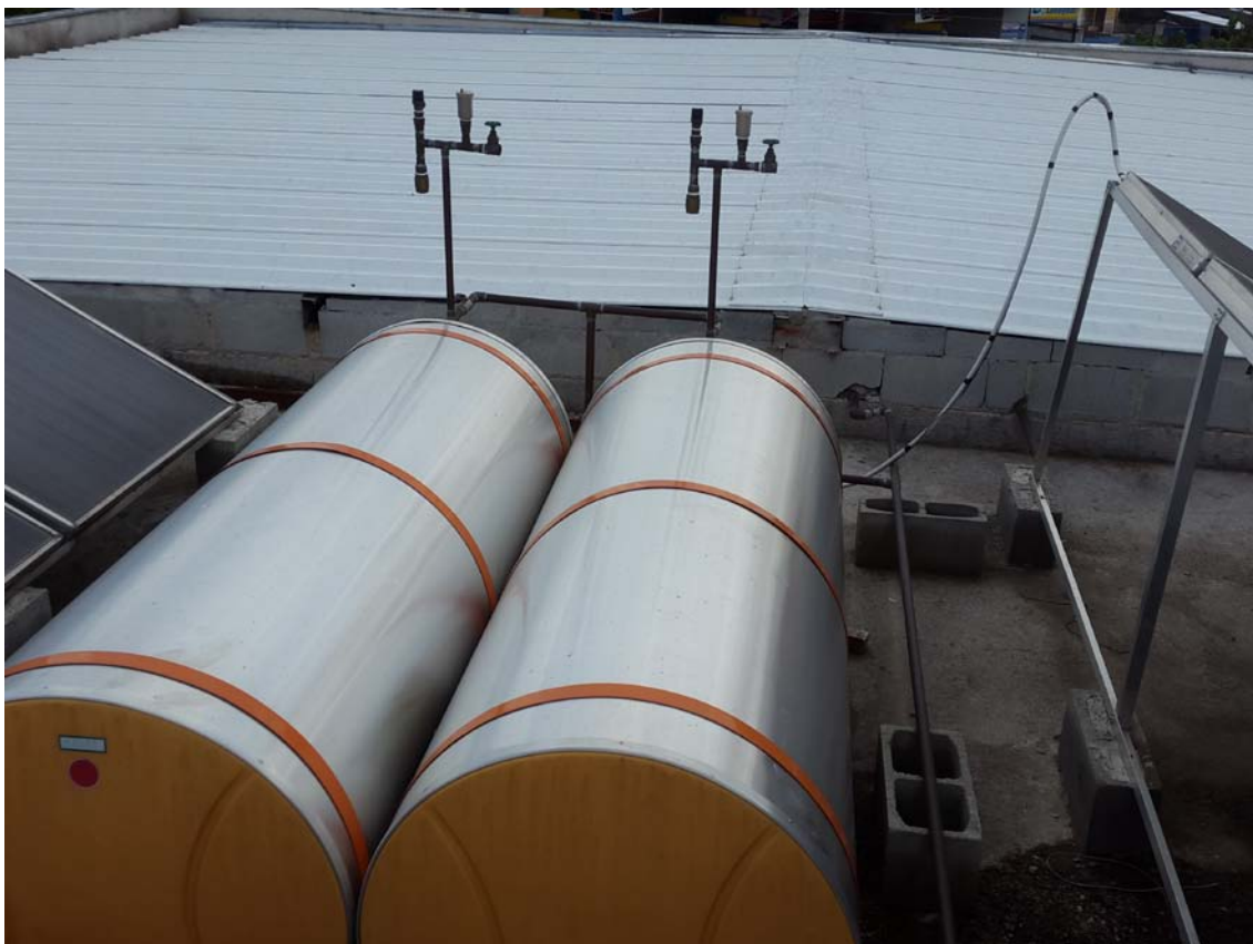
Fotografia 62 - Reservatórios térmicos - detalhe (Fonte: Levantamento de campo realizado pelo grupo)
