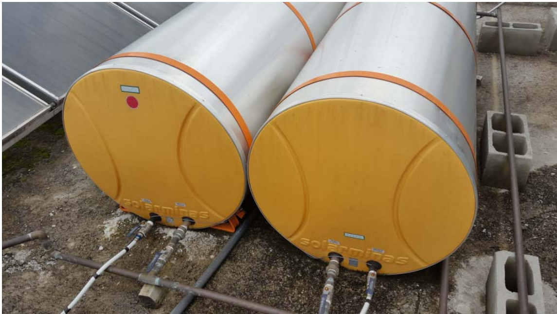
Fotografia 61 - Reservatórios térmicos - detalhes (Fonte: Levantamento de campo realizado pelo grupo)
