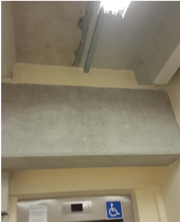
Fotografia 49 - Fissuras próximo ao elevador (CEI) (Fonte: Levantamento de campo realizado pelo grupo)
