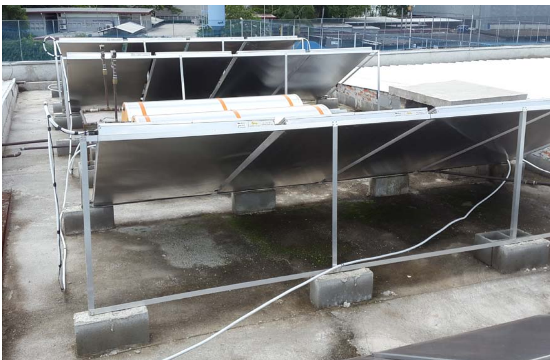
Fotografia 63 - Localização do reservatório térmico entre as placas solares (Fonte: Levantamento de campo realizado pelo grupo)
