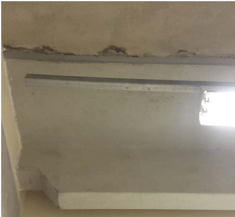
Fotografia 50 - Detalhe da fissura próxima ao elevador (CEI) (Fonte: Levantamento de campo realizado pelo grupo)
