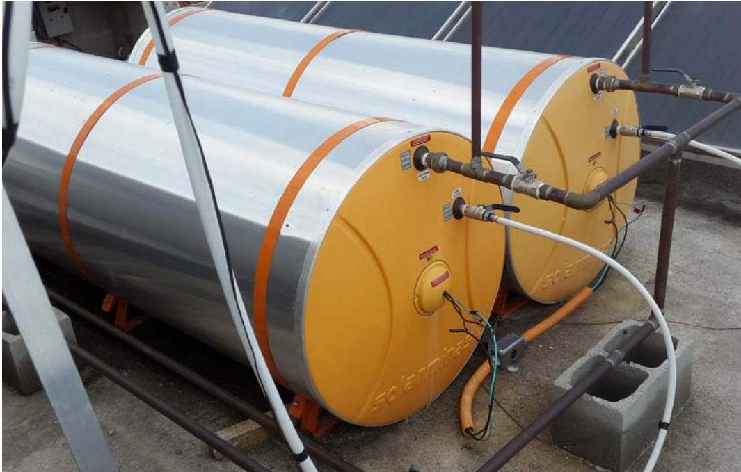
Fotografia 42 - Reservatórios de água quente (CEI) (Fonte: Levantamento de campo realizado pelo grupo)
